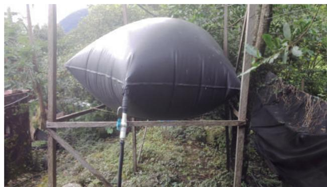
**Figura 3.** *Reservorio de gas de biodigestor.*
