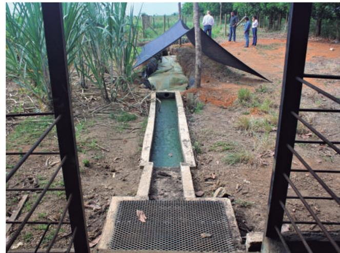
**Figura 8.** *Caja de recolección de sólidos y biodigester en mantenimiento cubierto con polisombra. Finca Cumar, vereda Guasipati.*
