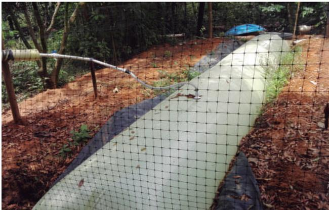
**Figura 7.** *Biodigester con filtro instalado. Finca Ebenezer, vereda Santa Bárbara.*
