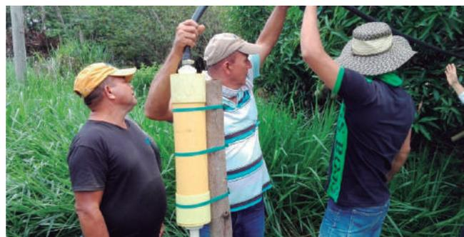
**Figura 5.** Instalación de filtro.
