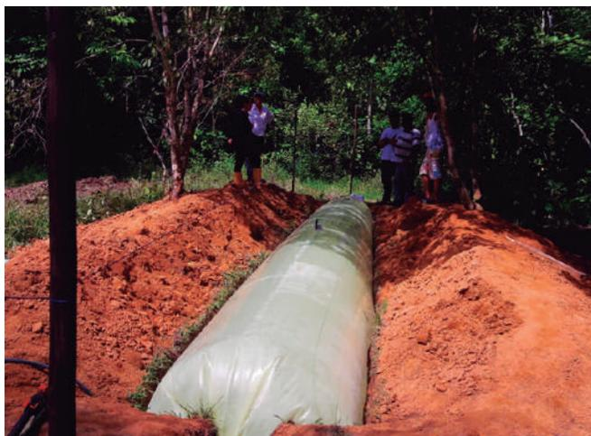
**Figura 2.** *Biodigestor finca Canagüei, vereda Nuevas Fundaciones.*
